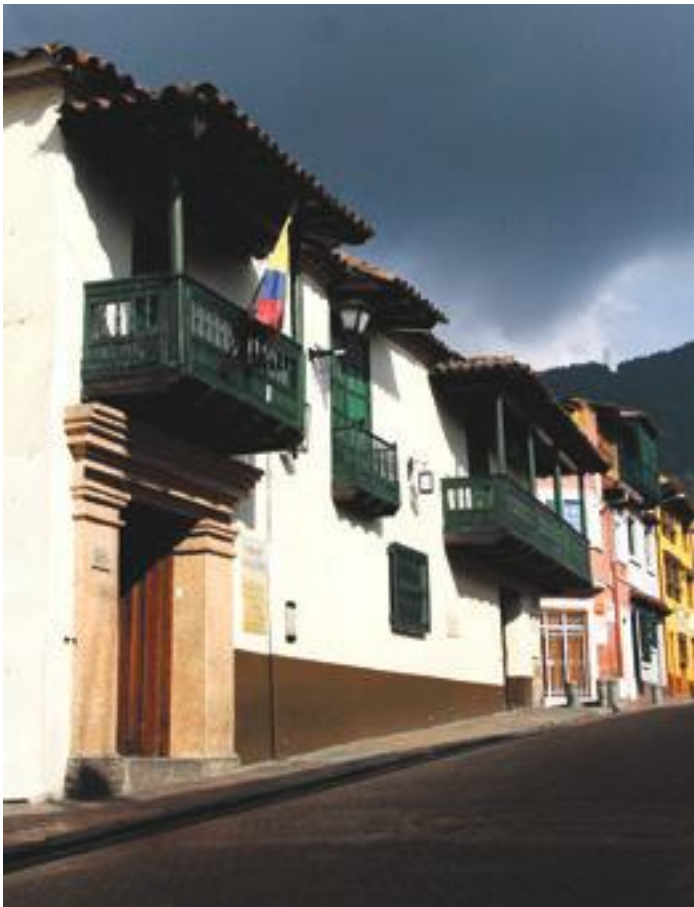
Fachada de la Fundación Gilberto Alzate Avendaño, 2012, Bogotá. Foto: Sergio Tapia, FUGA.
