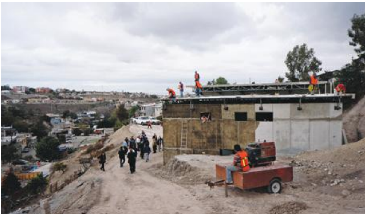
Avances de la obra de La Granja Transfronteriza, noviembre del 2012, Camino Verde, Tijuana, Baja California. Foto: Torolab.
